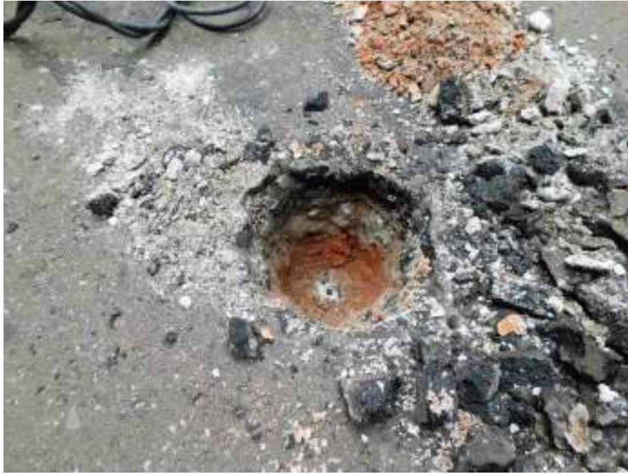
Fot nr 16 Odkrywka warstw na stropie
