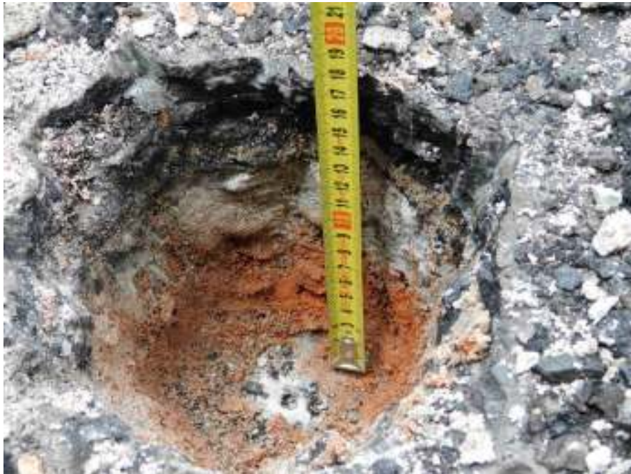
Fot nr 17 Odkrywka warstw na stropie
