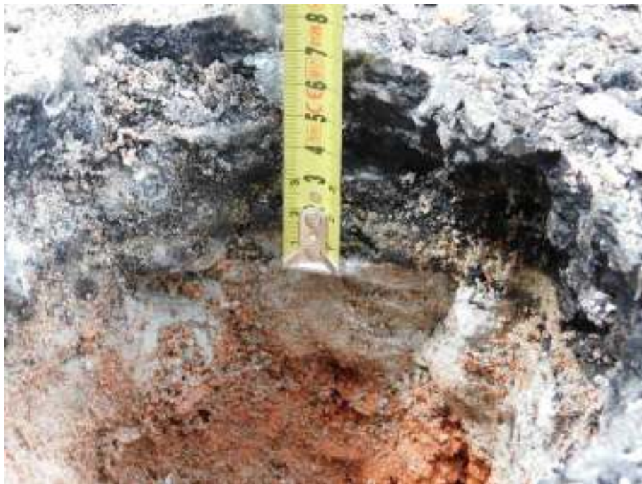
Fot nr 19 Odkrywka warstw na stropie
