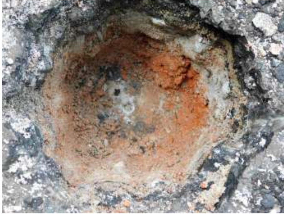
Fot nr 18 Odkrywka warstw na stropie
