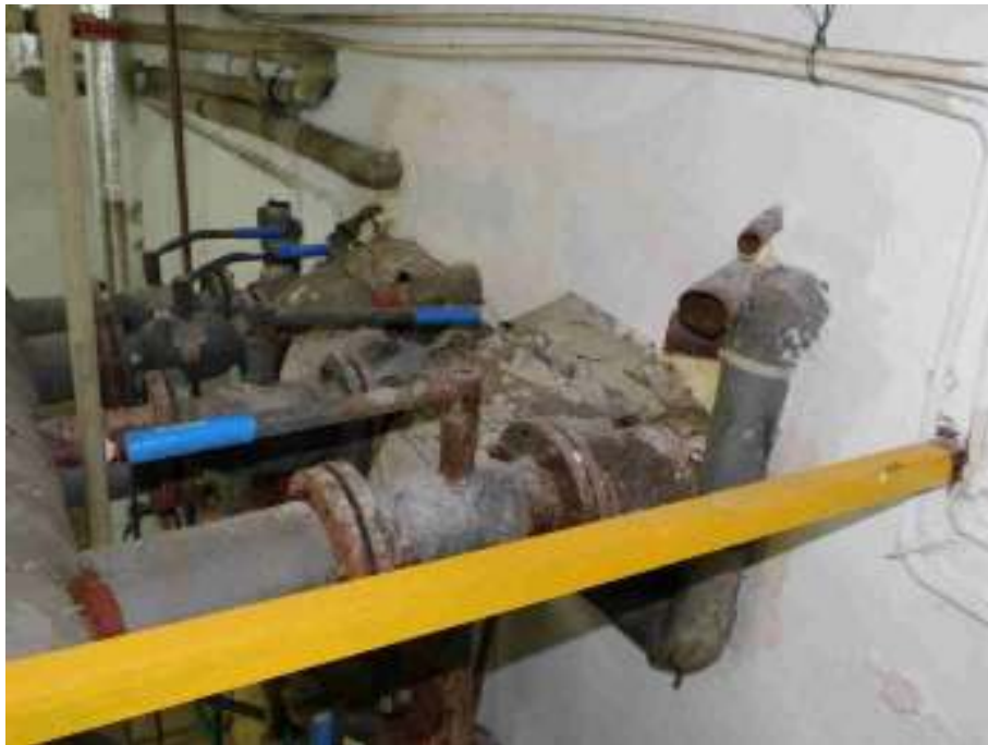
Fot nr 15 Widok zawilgoceń ściany.
