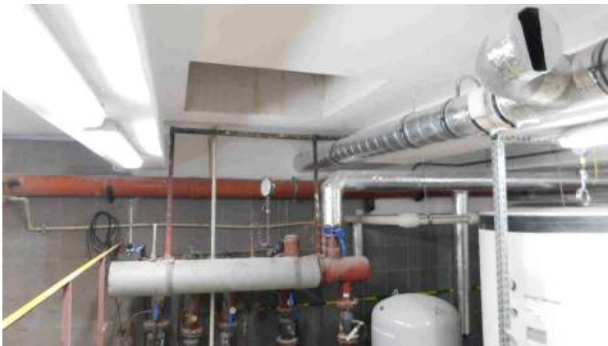
Fot nr 3 Widok ogólny pomieszczenia
