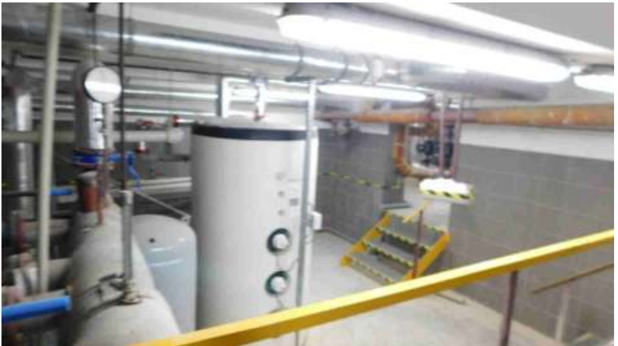
Fot nr 2 Widok ogólny pomieszczenia
