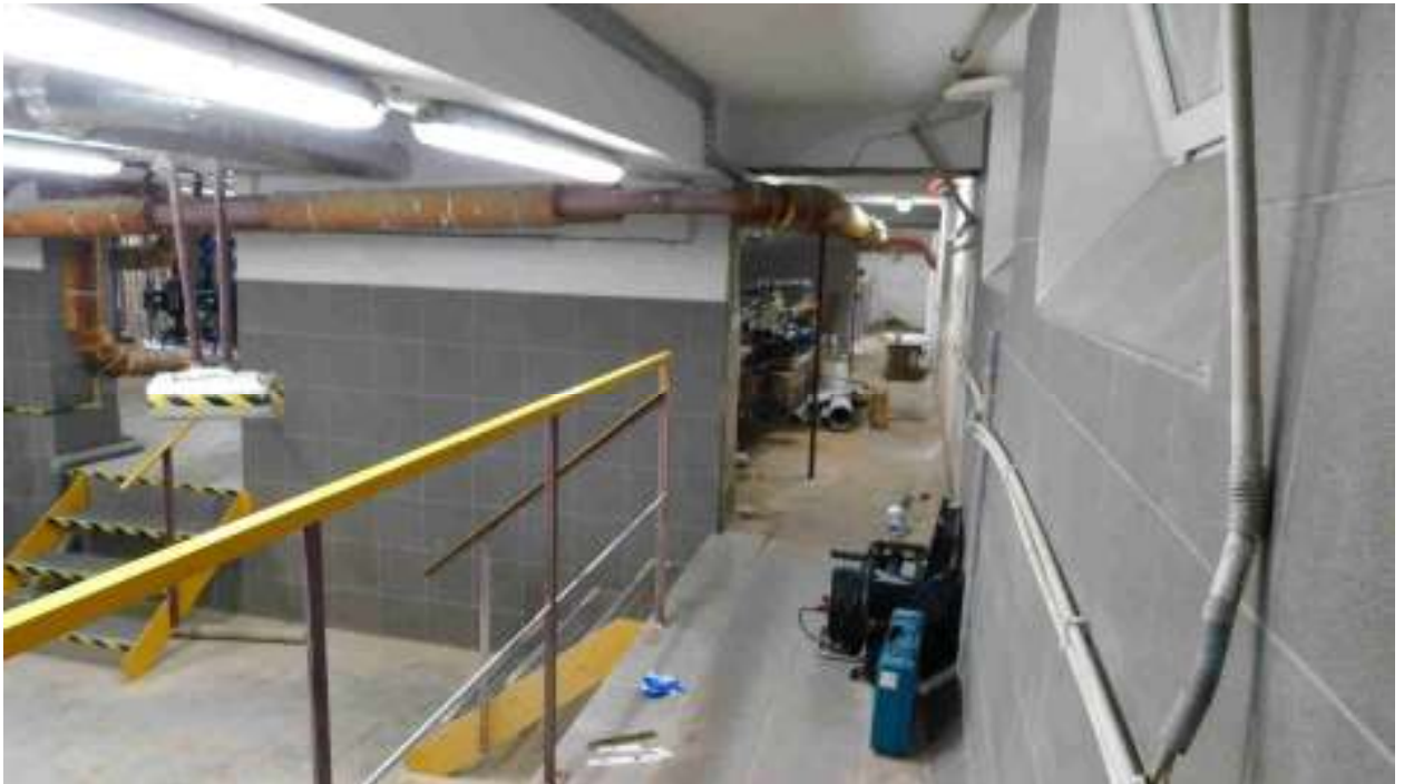
Fot nr 1 Widok ogólny pomieszczenia
